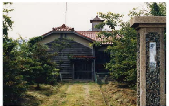
明治揚水機場 (安城市東端町)
