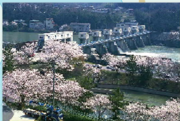
現頭首工全景 (1958～)
