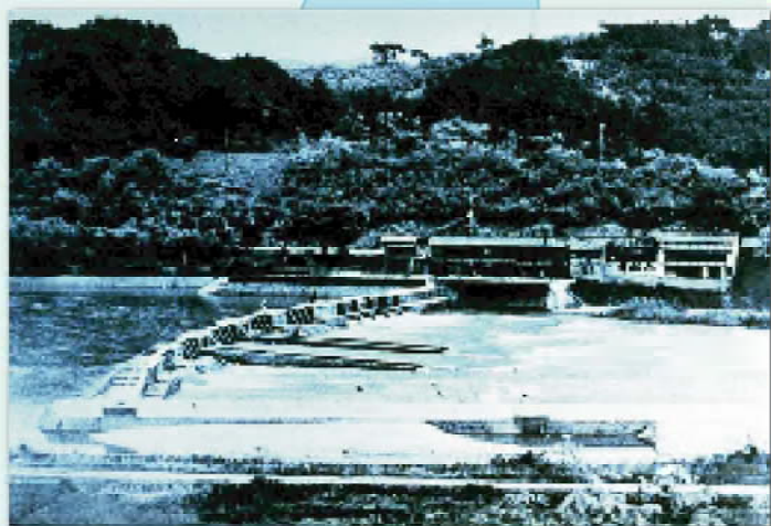
旧頭首工全景 (1902～1957)
