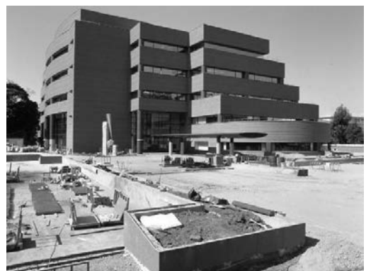
図5 建設工事中の当館
