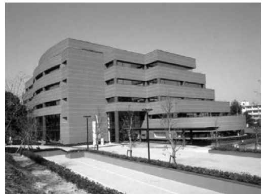
図 8 建物外観（竣工後）
